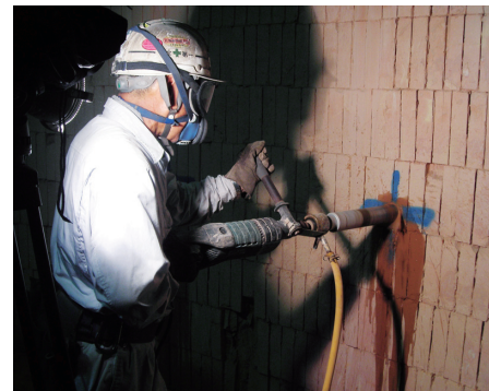
写真1 固定部コアボーリング
