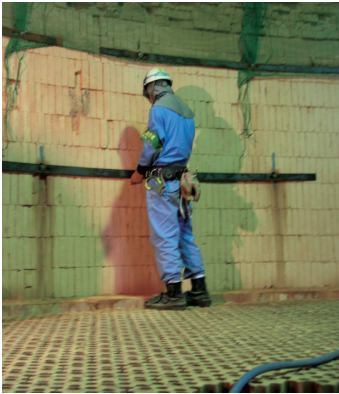
写真3 固定バー取付
