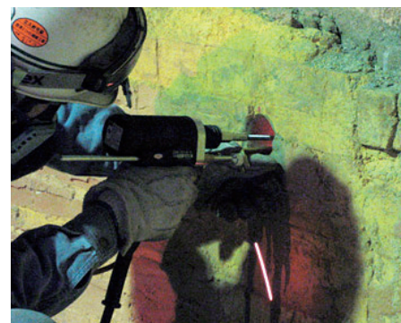
写真2 固定ピン溶接
