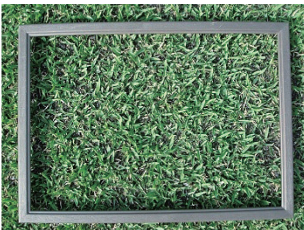
写真1 熔融スラグ施工部
