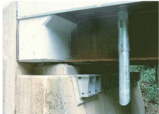
図6 既設下部工を再利用したパネルブリッジ
