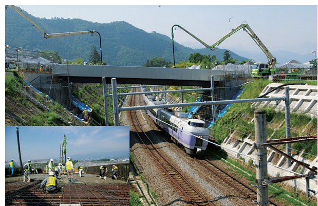
図8 急速施工事例(跨線橋)
