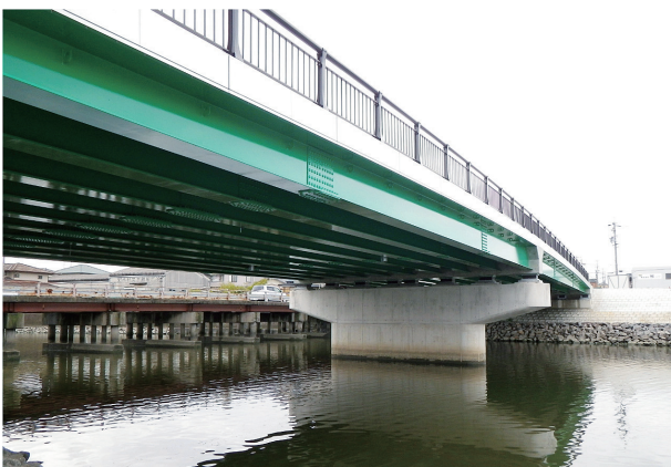
図1 パネルブリッジ写真
