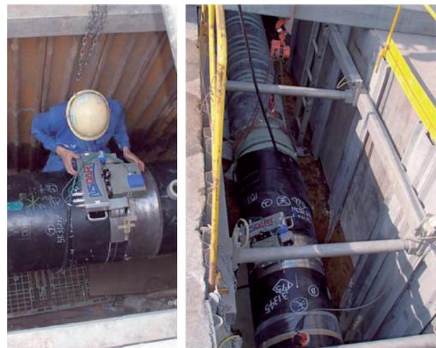
(a) 自走撮影装置の設置状況 (b) 自動撮影状況
