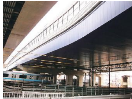
写真1 鉄道上の鋼桁橋
