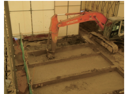
仮設テント内での攪拌混合
