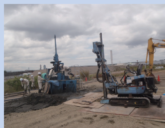
土壌浄化状況
