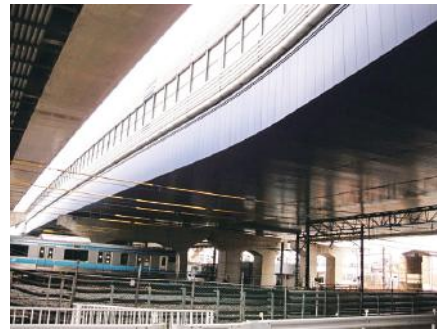
写真1 鉄道上の鋼桁橋
