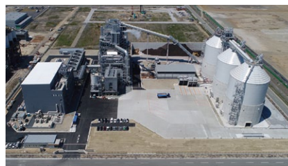
苧田バイオマス発電所
