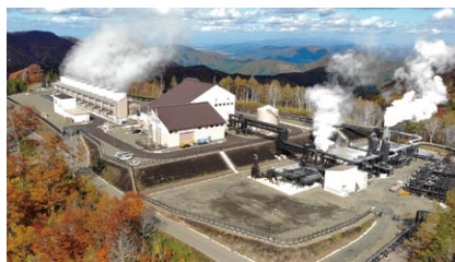
山葵沢地熱発電所
