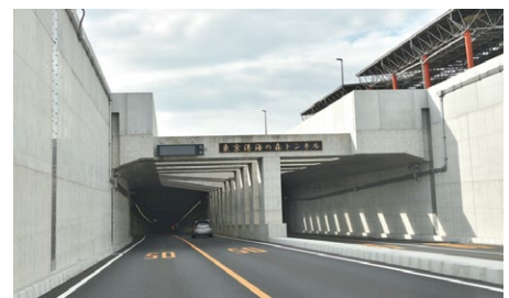
東京港海の森トンネル 沈埋函
