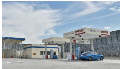
東京大井水素ステーション
