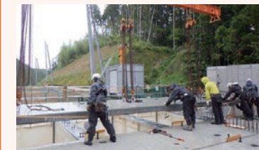
宮城県石巻市/崎山橋
