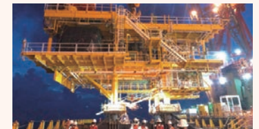
海洋天然ガス生産設備(タイ湾)
