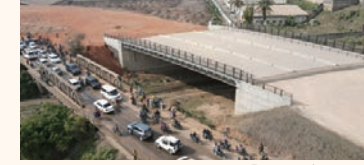
タンザニア連合共和国合床版橋「パネルブリッジ®」
