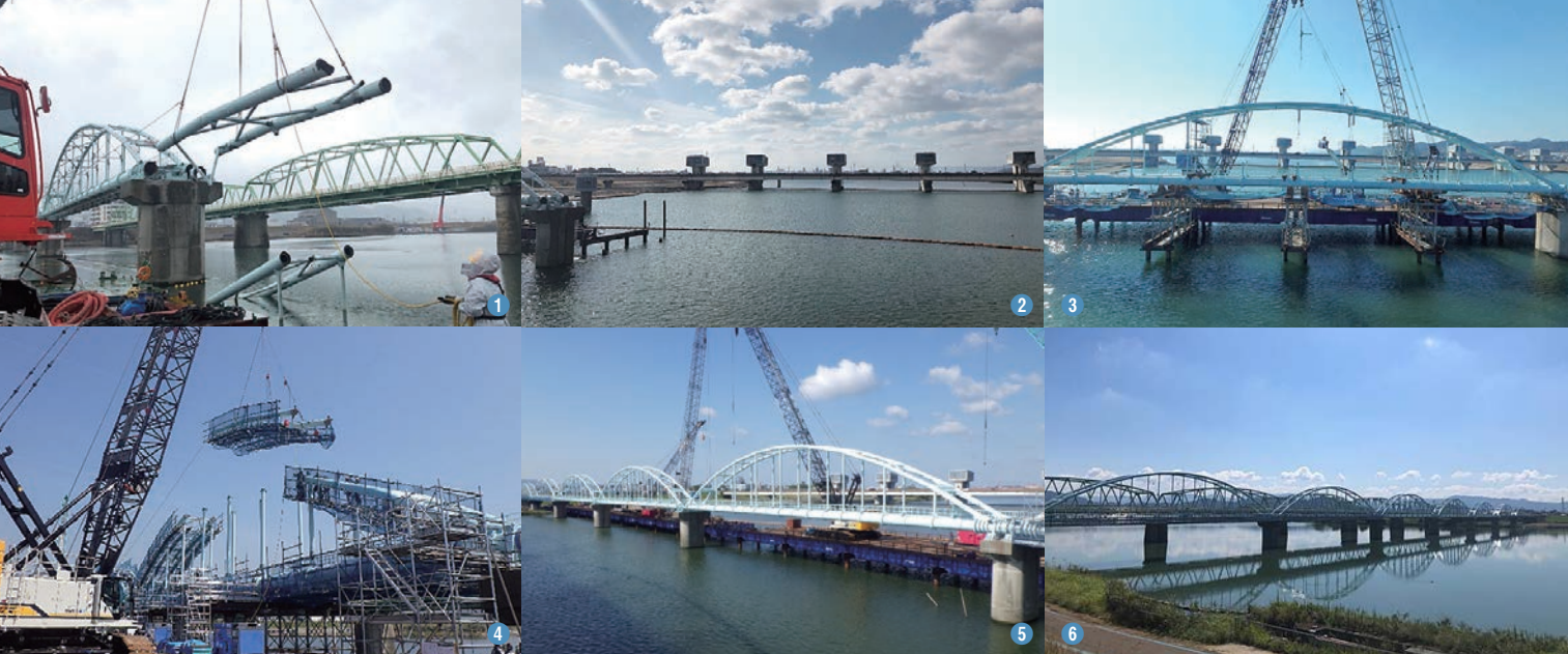
①水管橋落橋部撤去引上／10個に切断した上で、慎重に作業を進めていく ②落橋部撤去引上完了／最大の難関を予定工期よりも早期に終え、工事の体制が整う ③仮設橋設置／河川内という条件の作業現場にアクセスするために設置する ④新設水管橋架設／現地で組み立てた作業船に搭載したクレーンで進めていく ⑤仮設橋撤去／役目を終えた仮設橋を分解して撤去する ⑥河川内工事完了／水かさが増して工事が困難になる夏期までに無事終了した
