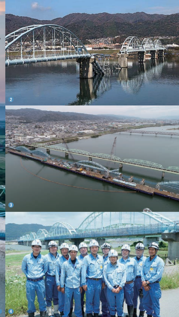
①一番手前に見えるのが復旧工を終えた水管橋。崩落時には、川の左手奥まで続く街の約6万世帯が断水に見舞われた ②全国ニュースでも報じられ社会に衝撃を与えた、水管橋中央部の崩落現場 ③仮設栈橋を設置して行われた復旧工事 ④困難な復旧工事を成し遂げた日鉄P&Eの担当者たち
