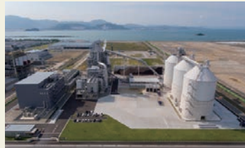
荻田バイオマス発電所
