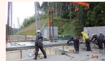
宮城県石巻市/崎山橋
