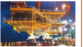
海洋天然ガス生産設備(タイ湾)
