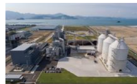
荻田バイオマス発電所
