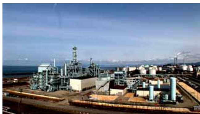
図7 GTL実証プラント全景 Fig.7 Overview of JAPAN-GTL demonstration plant
