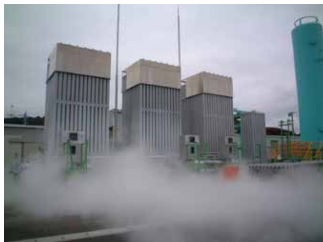
図1 Site X における空温式気化器からの冷気白煙 Fig.1 Cooled fog from air fin LNG vaporizer at Site X
