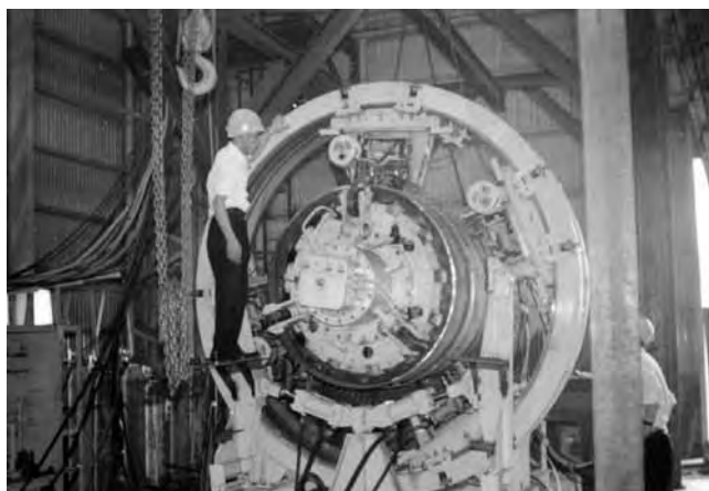
写真1 APW-400改 パイプレイバージ用自動溶接システム（1970年代）
