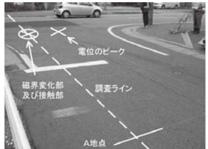
図22 調査状況 (事例1)
