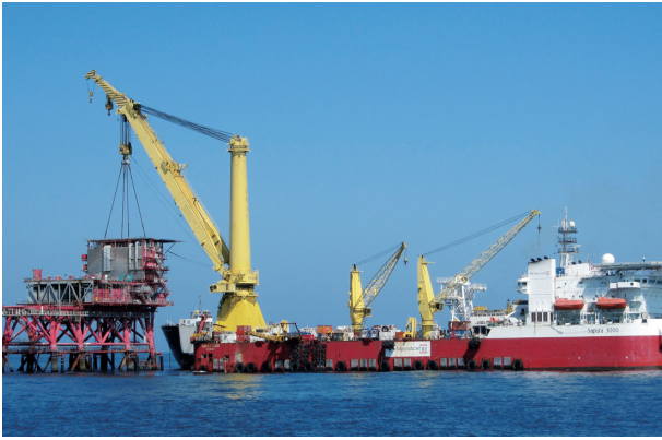
図4 Sapura 3000による上載構造物撤去作業状況 Fig. 4 Topside removal work by Sapura 3000
