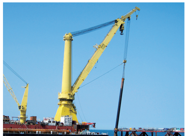
図10 杭撤去作業状況
