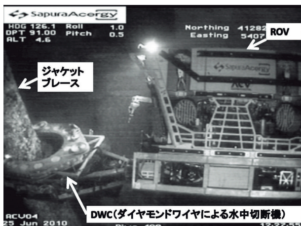
図9 ROVによるDWC切断装置のジャケット部材への海中での取付状況
