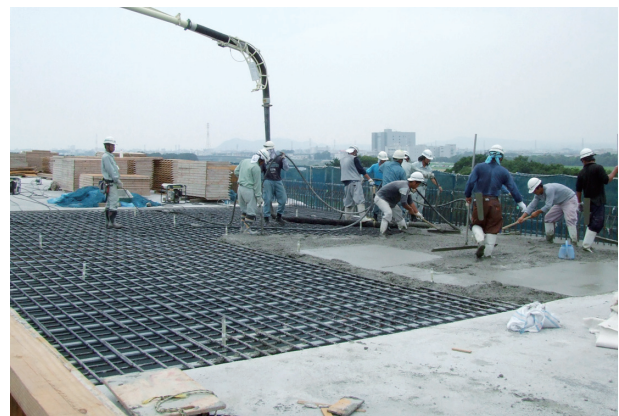
図26 コンクリート打設状況 Fig. 26 Concrete casting
