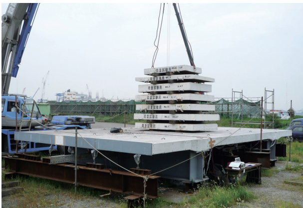
図18 実物大施工実験 Fig. 18 Full-scale construction test
