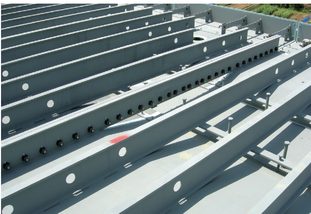
図23 引張継手接合 Fig. 23 Tension joint
