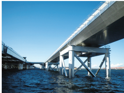
図2 NS カバープレート写真 Fig. 2 appearance of NS Cover Plate Bridge
