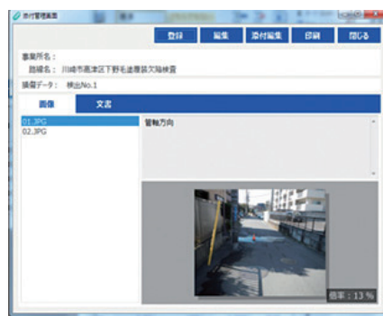
図4 損傷を検知した場所の状況写真(検知場所は、コーンで示す)
