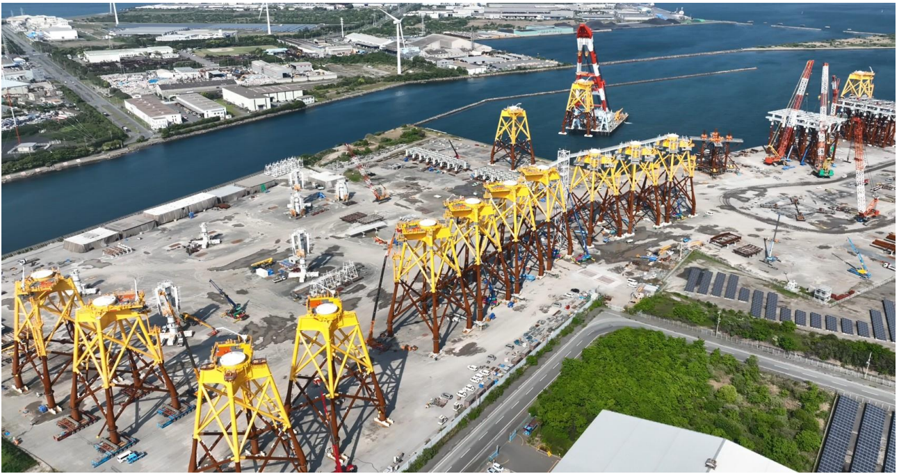
若松工場（石狩湾新港ジャケット式基礎製作時）
