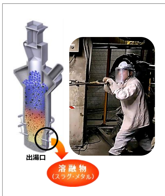
【ガス化熔融炉出湯口／作業員による清掃作業】
