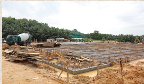
ヤシ林に囲まれた造成地で、コークス代替品の工場建設が進む
