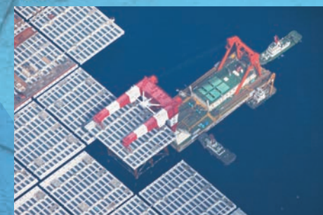
低頭起重機船でジャケットを据付ける様子
