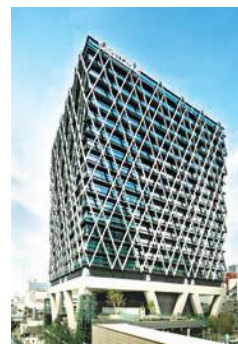
木村様が設計を担当された、大規模オフィスビル「タイヤゲート池袋」(東京都豊島区)。当社は「免震NSUダンパー®」の供給と本体鉄骨および外殻部鉄骨の一部製作を担当。
