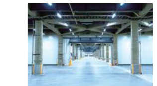
上:1階倉庫内観 下:発電量約2MWの太陽光パネル
