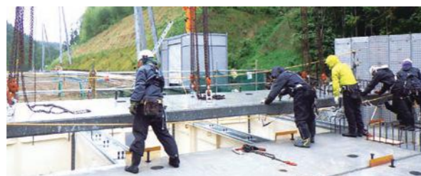
右:床版の接合施工を行う様子 左:プレキャスト床版を架設する様子
