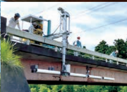
橋面上から桁下を点検中の橋梁点検ロボット
