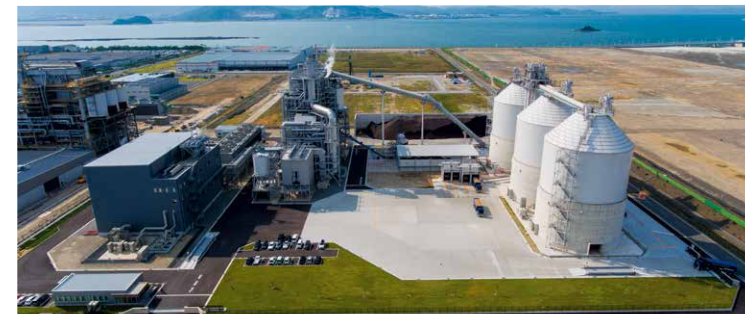
■ バイオマス発電プラント
