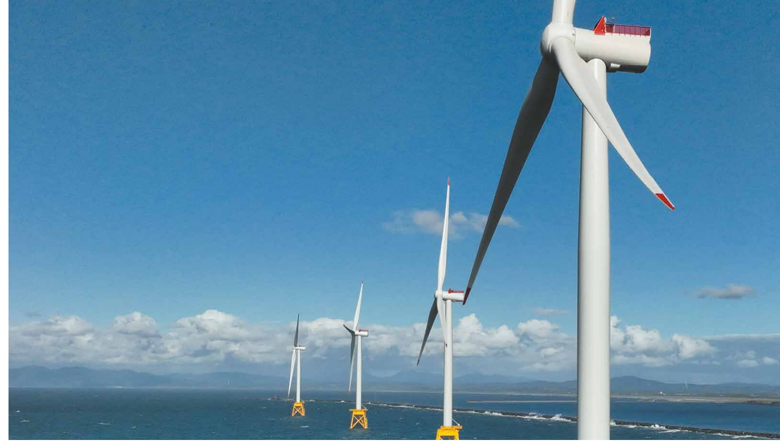
■ 洋上風力発電施設
