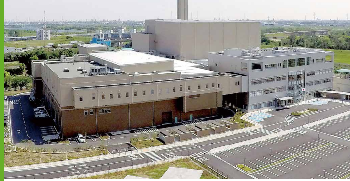
■ シャフト炉式ガス化溶融炉
