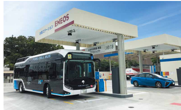
■ 水素ステーション
