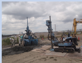
土壌浄化状況
