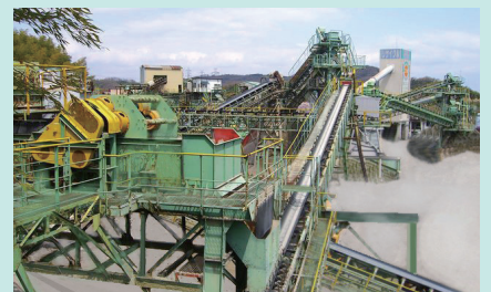
汚染土壌洗浄プラント
