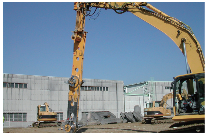
原位置での攪拌混合
