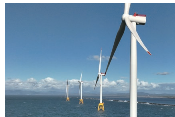
石狩湾新港洋上風力発電所
