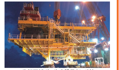
海洋天然ガス生産設備(タイ湾)
