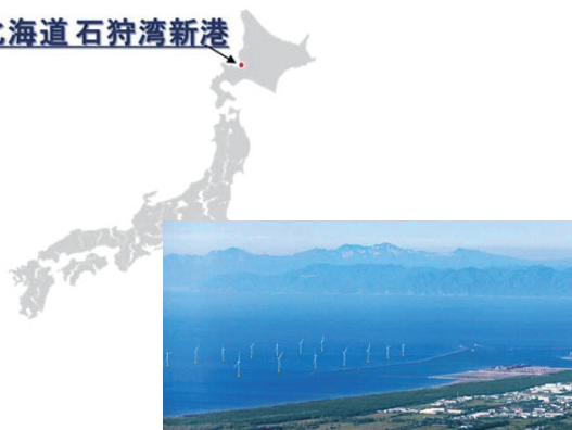
図1 石狩湾新港洋上風力発電所
