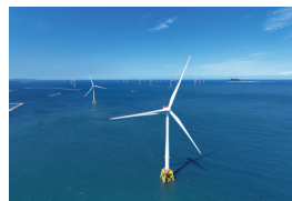
北九州響灘洋上ウインドファーム
