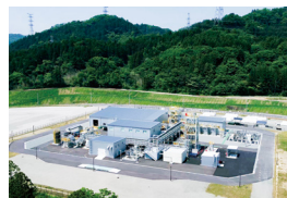
第2世代バイオエタノール化 実証設備
