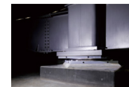
鉄の免震装置「NS-SSB®」
