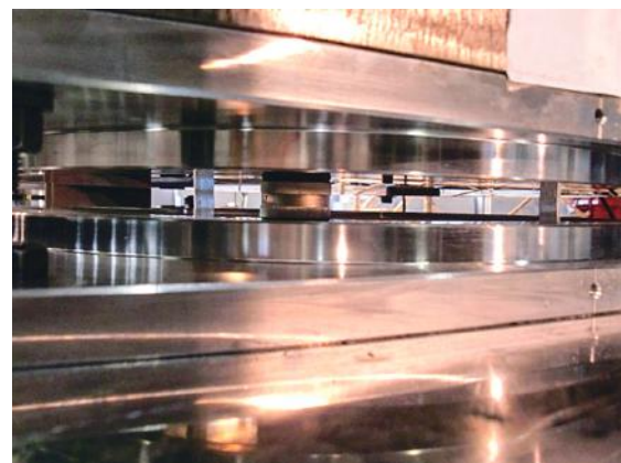
図8 球面すべり支承設置状況(写真) Fig. 8 NS-SSB Under the Frame Structure
