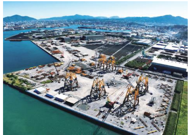
図16 日鉄鋼構造で製作中のジャケット構造 Fig. 16 Jacket structure under construction at Nippon Steel Steel Structure Co., Ltd.
