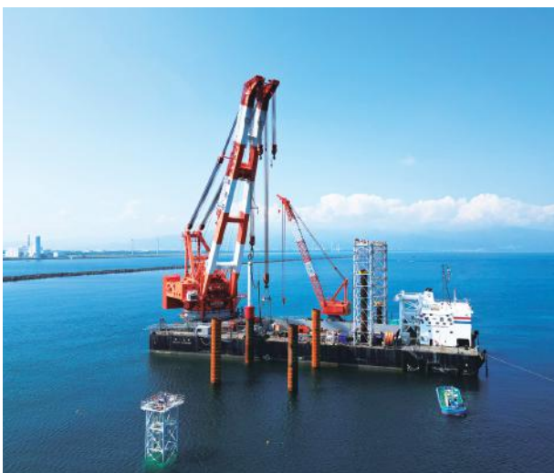
図15 現地海域での鋼管杭打設状況 Fig. 15 Installation of piles in the site
