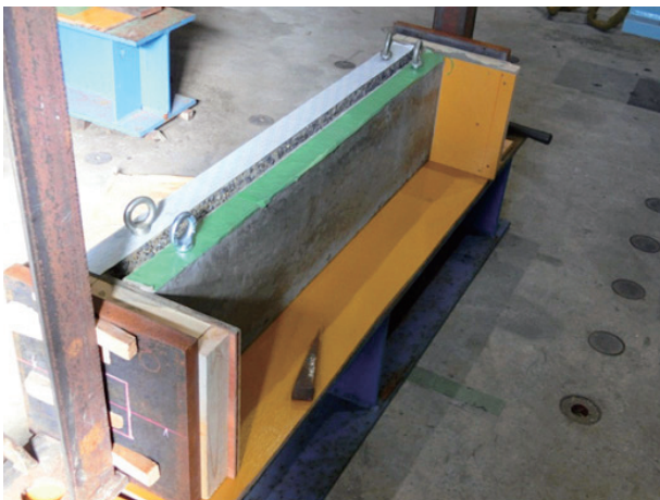
図3 オリジナル試験体①組立状況 Fig. 3 Appearance of the Original Specimen No. 1
