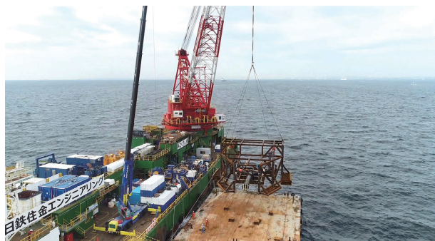
図9 第2くろしおによる PLEM 吊上げ
