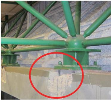
図1 支承部の被害(支承基礎コンクリートの剥落)
