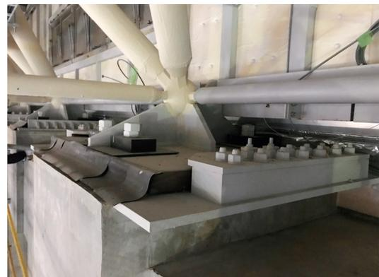
図7 御殿場市体育館への設置状況(RC柱上に設置(写真上の赤丸部))
