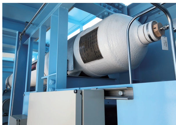
図1 FIBA製TYPE 2 蓄圧器 設置例
