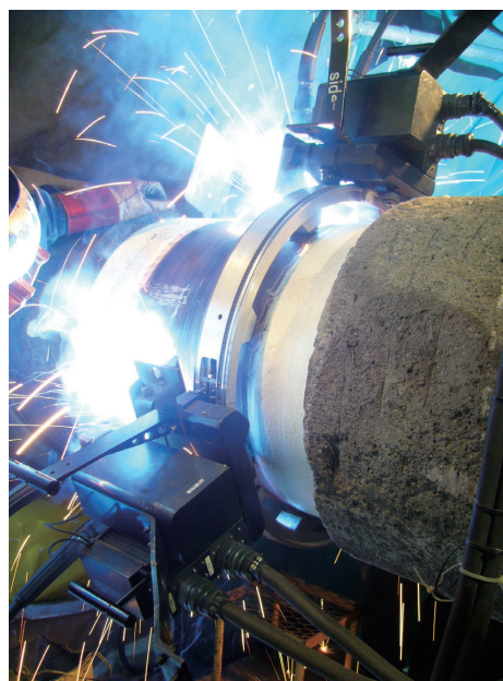
図6 RAIDENによるパイプライン溶接状況(写真)
