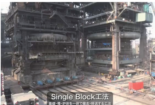
図15 シングルブロック工法実績(写真) Fig. 15 Single-module method records
