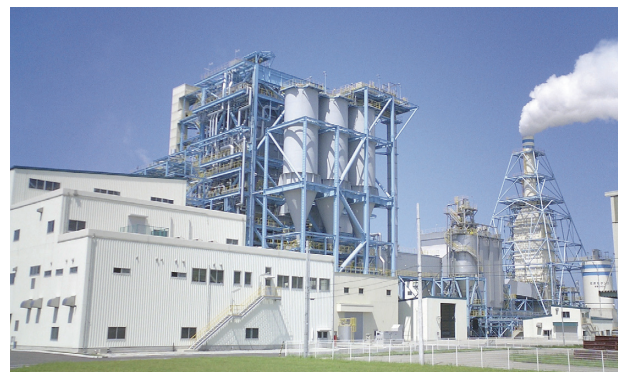
図1 フロンティアエネルギー新潟(発電所全景写真)
