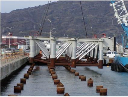
写真3 ジャケット据え付け(焼津漁港栈橋改修工事)
