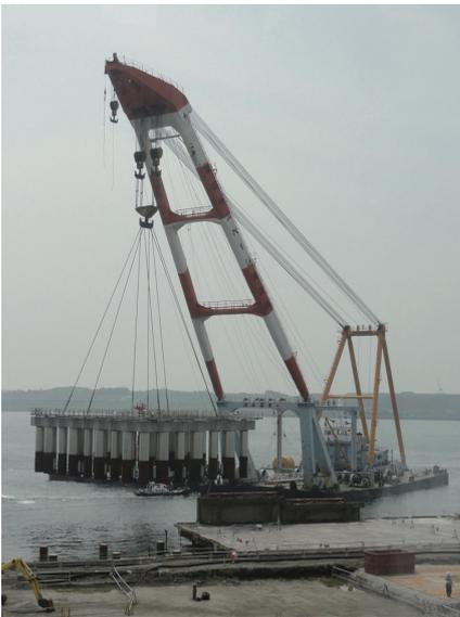
写真4 ジャケット据え付け(東京港10号地栈橋改修工事)
