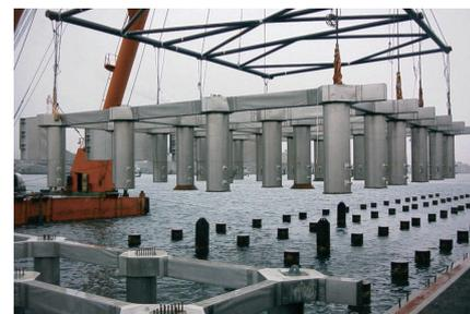
写真2 ジャケット据え付け(二島岸壁改修工事)
