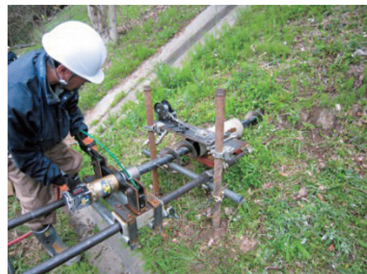
写真-5 工具による施工状況
