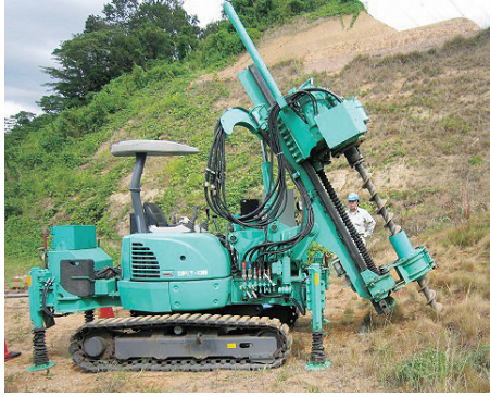
写真-3 盛土斜面施工の様子
