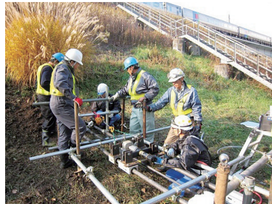
写真-4 鉄道盛土での実斜面施工試験
