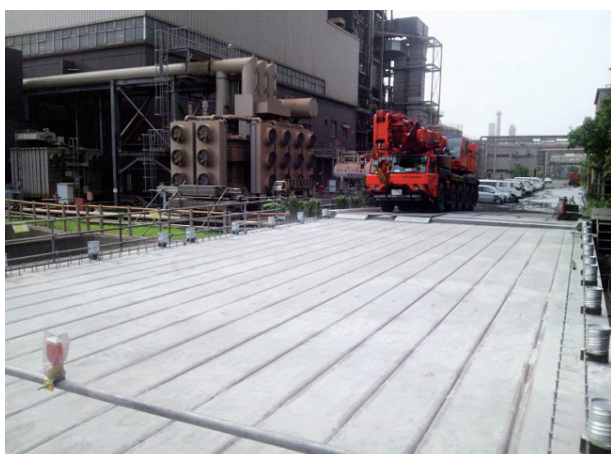
図7 君津共同火力西橋道路の架設状況
