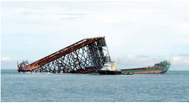
図1-1 ジャケットロンチング状況(写真) Fig. 1-1 Launching of Jacket (photo)
