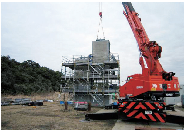
図6 施工状況 Fig. 6 Status of Construction
