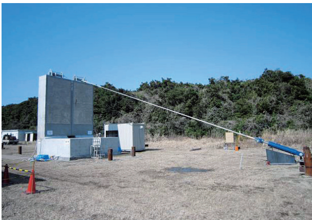
図7 静的荷重試験状況 Fig. 7 Static loading test
