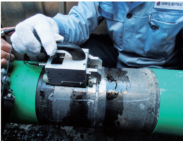
図4 150A 鋼管での走査状況
