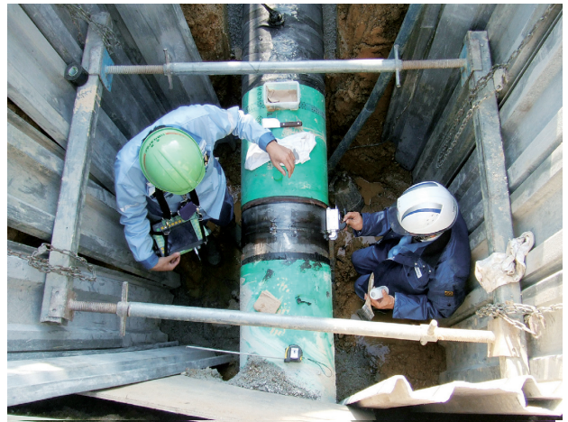
図2 400A 鋼管での会所内作業状況
