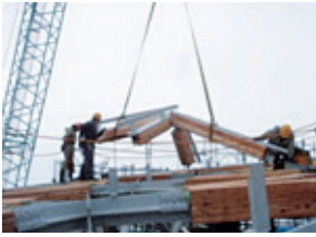
図18 建方状況(写真) Fig. 18 Erection(Photo)
