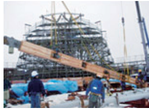
図19 柱材の吊上げ(写真) Fig. 19 Hanging of a column(Photo)
