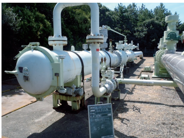
図4 検査ピグ用仮設設備例
